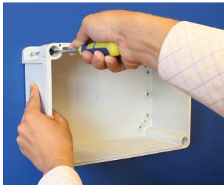
1. Прикрутите корпус к стене
