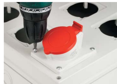
Монтаж розетки на 32 А
