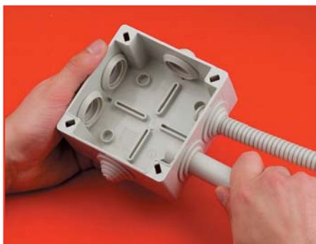
Заводим гофрированную и жесткую трубы
