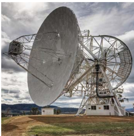
Системы управления и телекоммуникации
