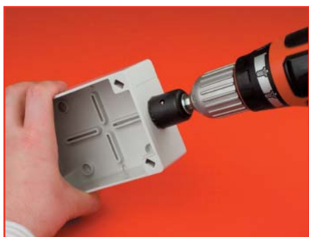
Сверлим отверстия необходимого диаметра
