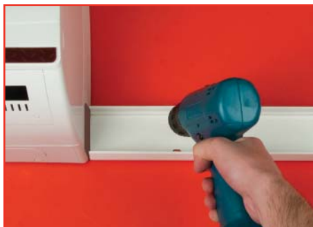
Закрепите основание короба на стене
