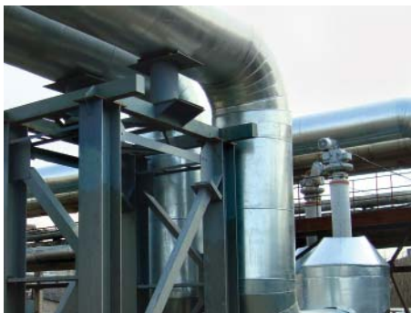
Городское и муниципальное строительство Уличные опоры инженерных коммуникаций
