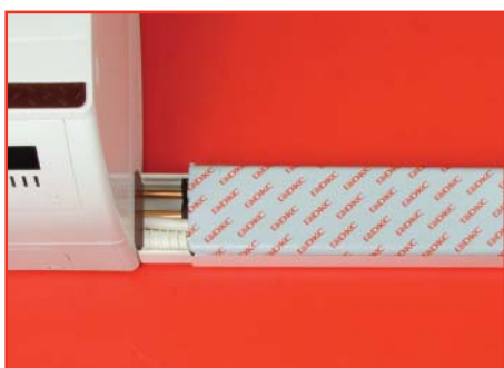
Закройте смонтированную трассу крышкой
